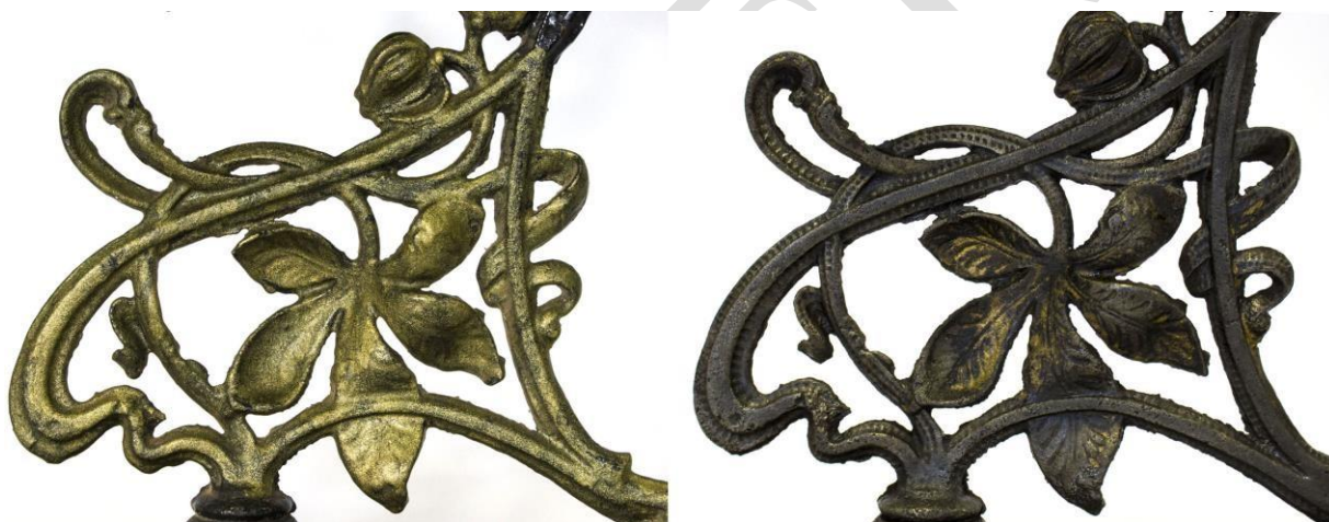
7. attēls. Pirms (pa kreisi) un pēc krāsas slāņa noņemšanas
