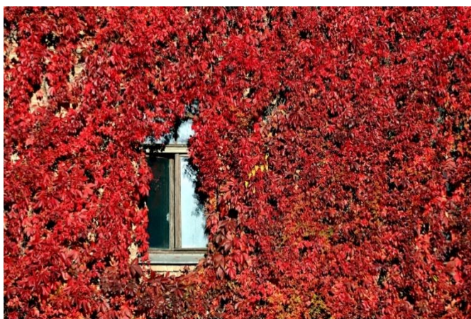
4. attēls. Ēkas fasāde
