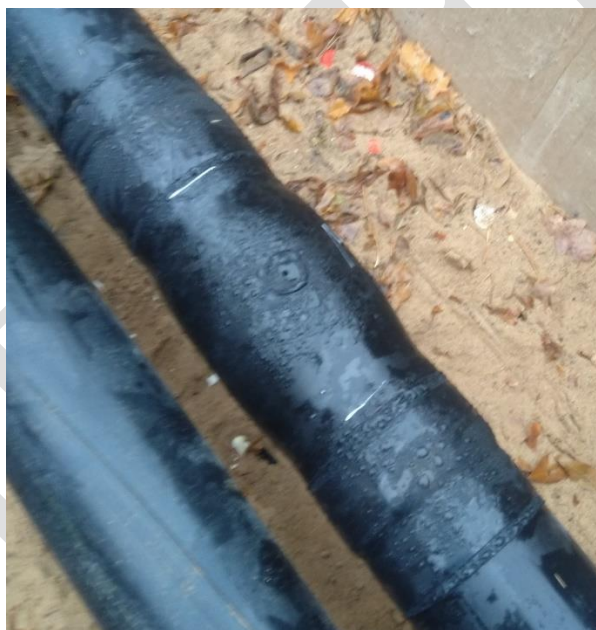
5. attēls. Termonosēdošā uzmava pēc montāžas
