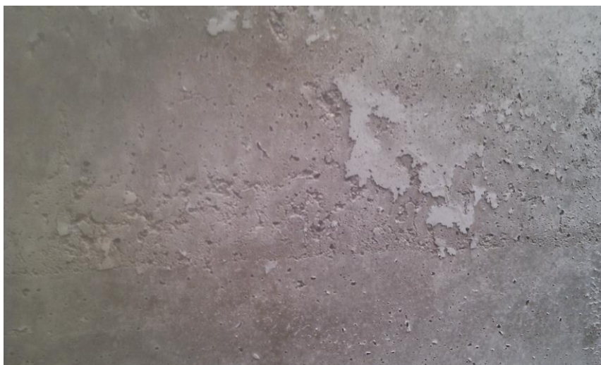
3. attēls. Betonētas sienas fragments
