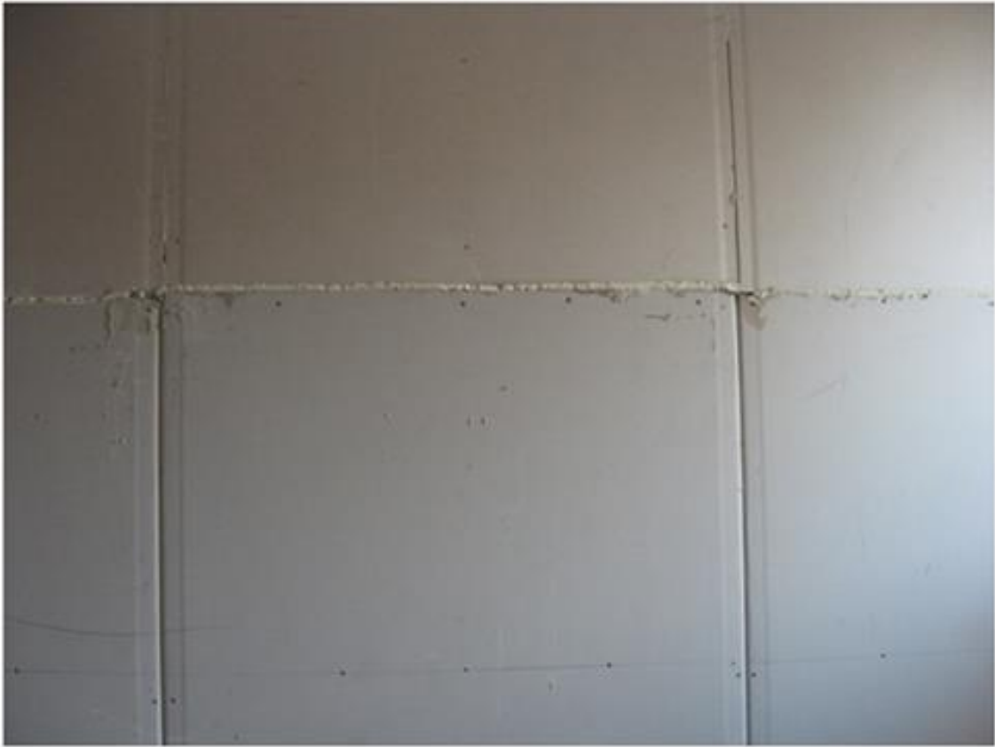
2. attēls. Ģipškartona plākšņu montāža
