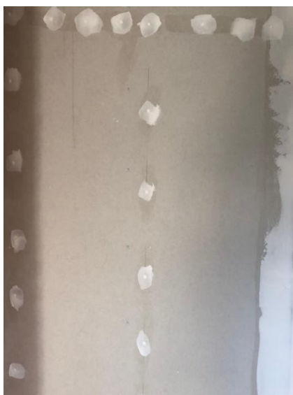
1. attēls Ģipškartona siena, kam veikta šuvju un skrūvju vietu špaktelēšana
