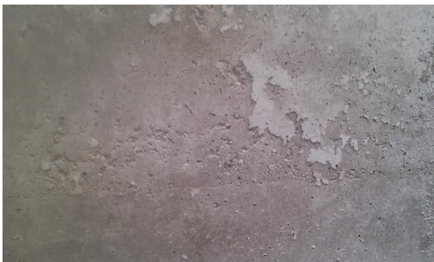
2. attēls. Betonētas sienas fragments
