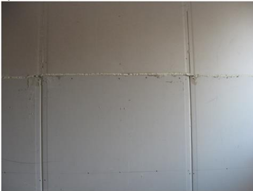
1. attēls. Ģipškartona plākšņu montāža
