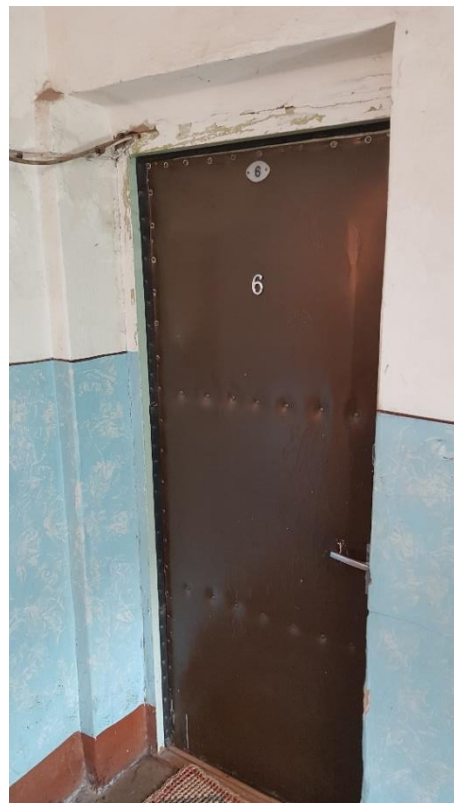
8. attēls. Sienu tehniskais stāvoklis 4
