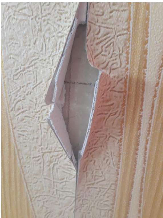
2. attēls. Tapešu līmēšanas defekts
