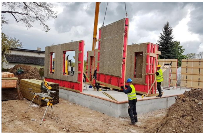
3. attēls. Sienas koka paneļu montāža
