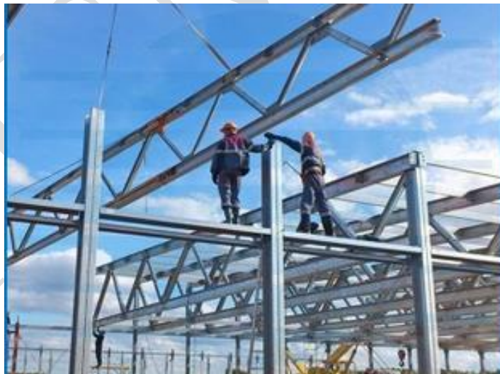
3. attēls. Metāla kopnes uzstādīšana uz kolonnām Attēlam ir informatīvs raksturs
